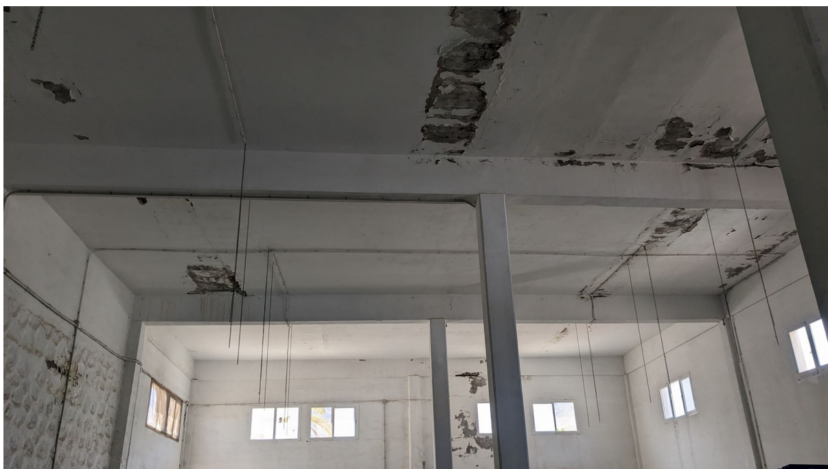
Ilustración 2 Deficiencias techos
